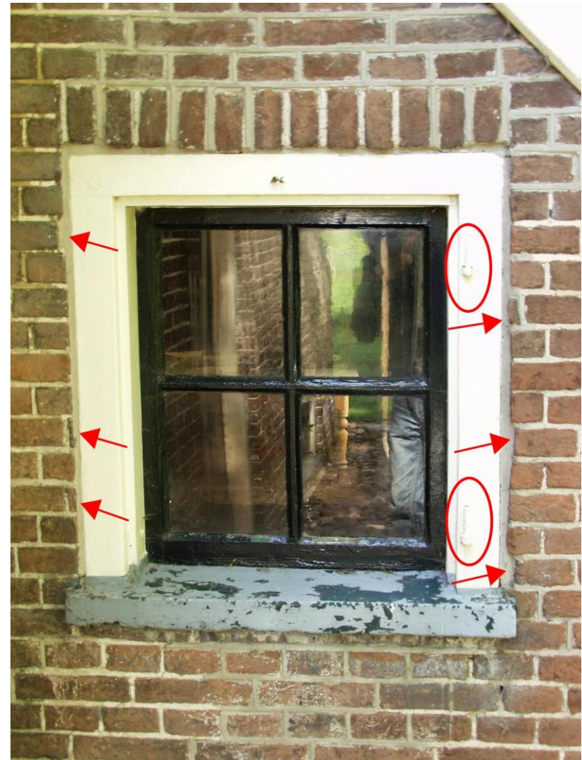
25. Pijltjes: onregelmatige beëindiging dagkanten. Omcirkeld de duimen voor het luikje.
