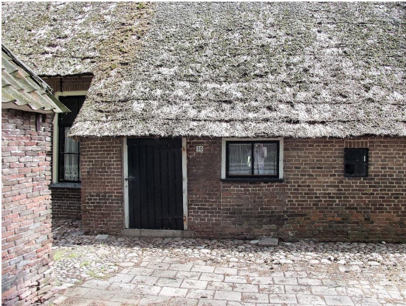
104 – 105. Reconstructie vensterindeling met het vierruitsraam van de uitkubbing.
