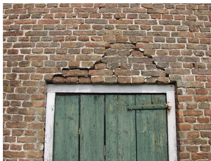
40. Deurvenster voergang mist rollaag.
