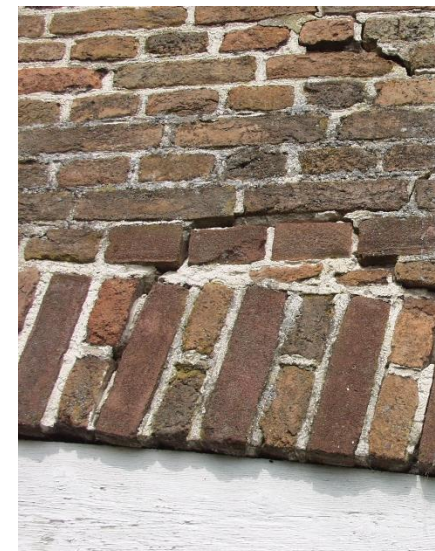
38. Detail ontlastingsboog.
