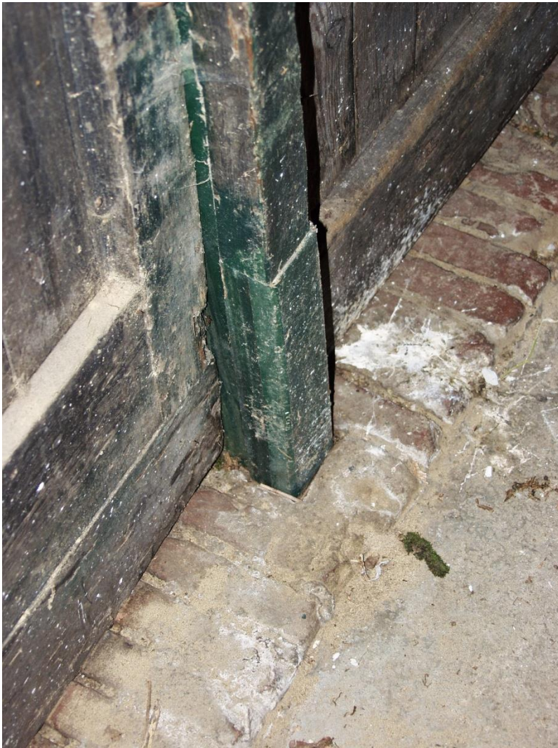
30. De voet van de stiepel valt in een holte van de baanderdeurdrempel.
