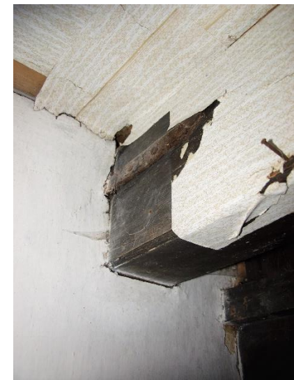
84. Zolderbalk met muuranker.
