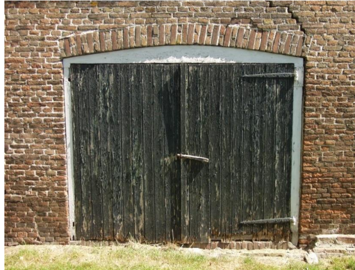
37. Deeldeur mist links duimen en gehengen.
