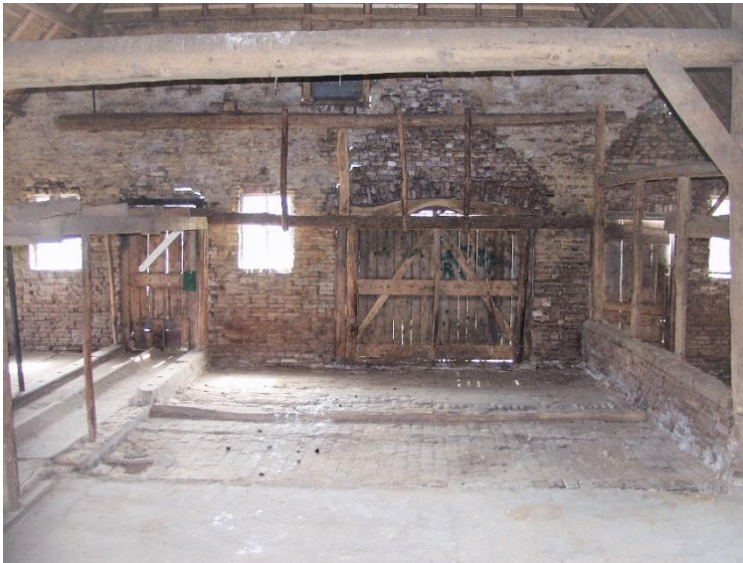
87. Dichtgegoide en bestratte potstal met zul.
