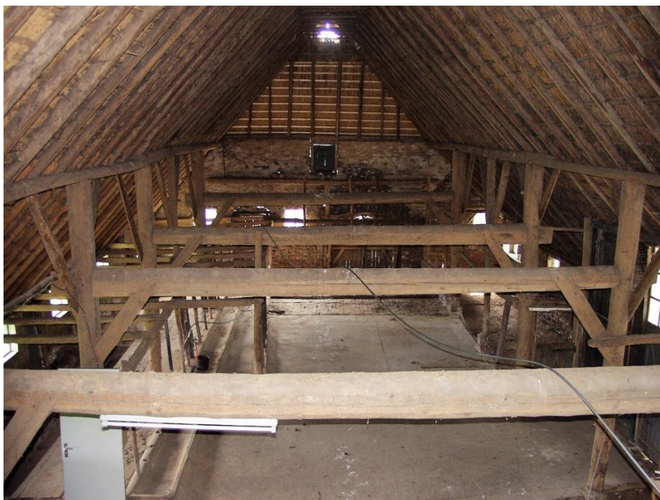
100. Gebintconstructie vanaf de zolder.
