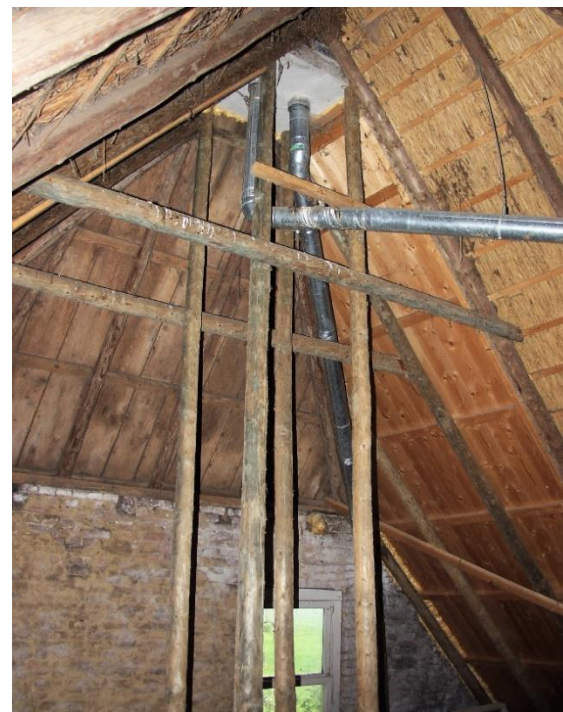
101. Houten dakbeschoot op plaats pannendak.
